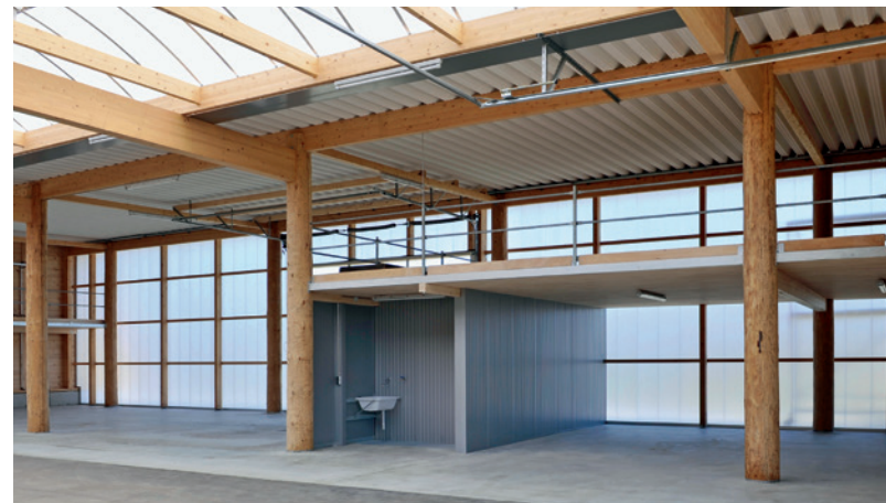
Die Lastabtragung beispielsweise erfolgt im Bauhof Frickingen über acht Weißtannen-Rundstämme.
