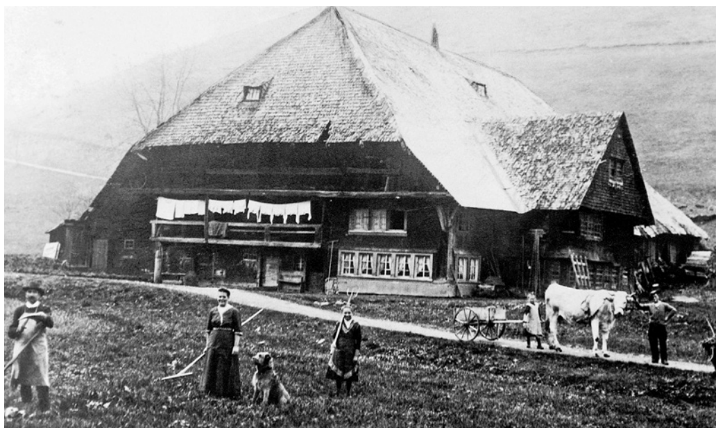
Mit Tanne erbaut: Der einstige Schochenbachhof im Katzensteig bei Furtwangen.
